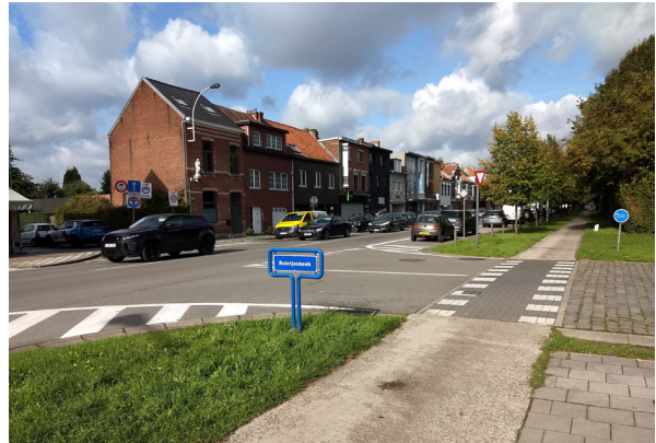
Een fietsoversteekplaats die een zijstraat oversteekt.
